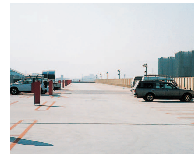
屋上・駐車場
